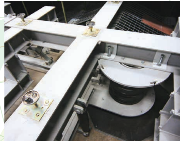
3次元免震装置にホストコンピュータを設置
