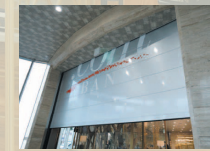
四国初。3メートル防水シャッターで災害時にも早期復旧を目指します。
